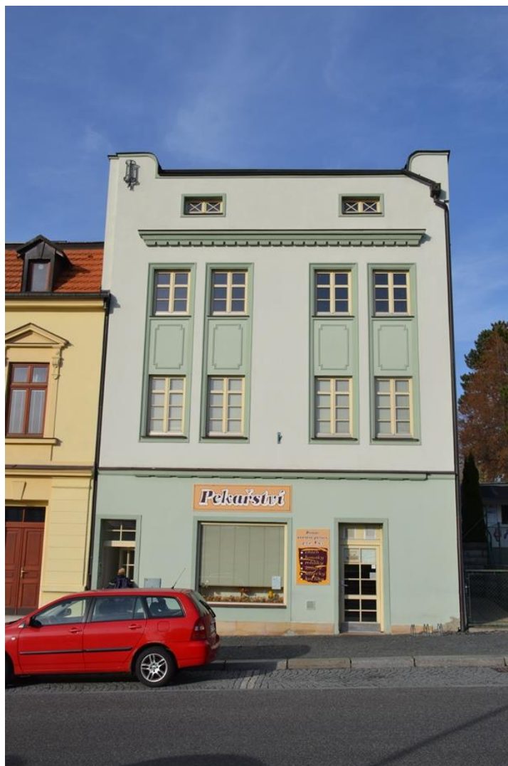
Východní objekt-jížní průčelí, r. 2022
