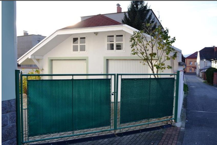
Garáže, východní průčelí, r. 2022
