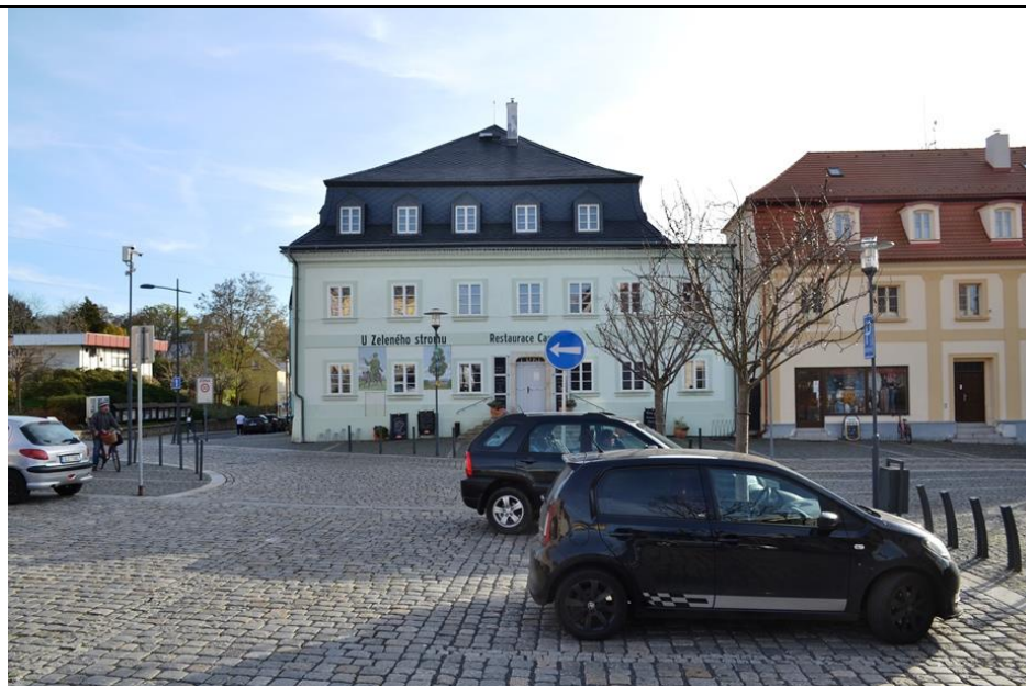
Severní průčelí, r. 2022
