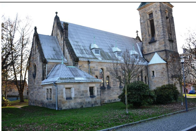
Severní průčelí a presbytář kostela, r. 2022
