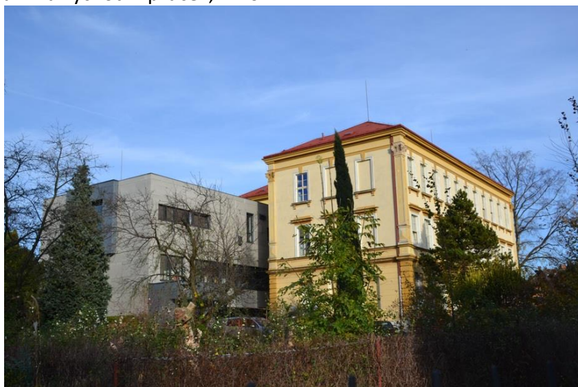
Přístavba a nástavba, r. 2022
