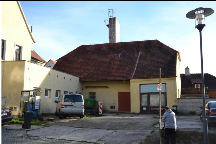
hospodářský objekt ve dvoře, severní průčelí, r. 2022
