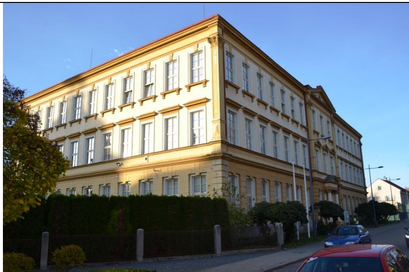
Jižní a východní průčelí, r. 2022
