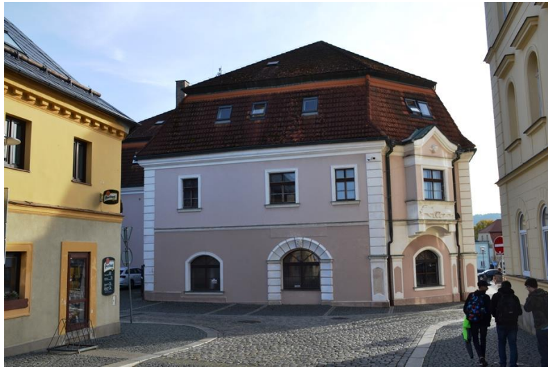
Severní průčelí, r. 2022
