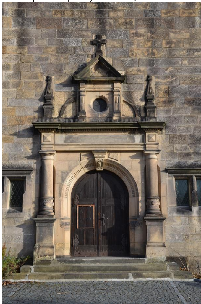
Portál hlavního vstupu, r. 2022
