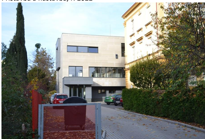
Přístavba a nástavba, r. 2022, pohled z Kostelní ulice
