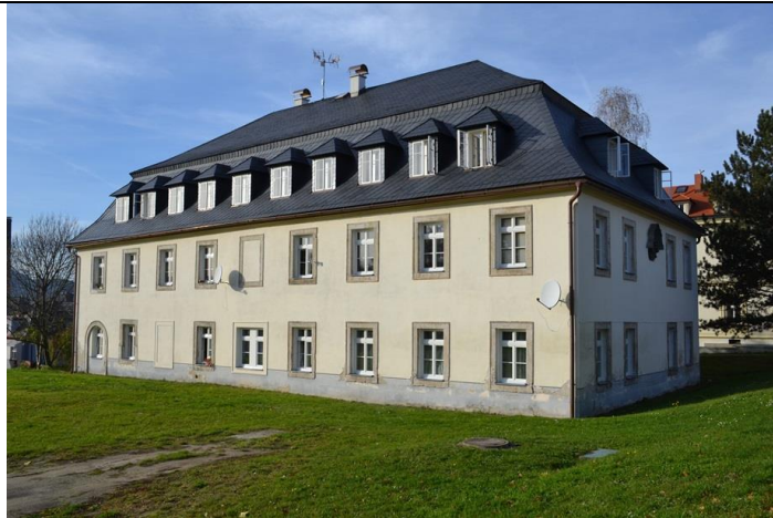
Jižní a východní průčelí, r. 2022
