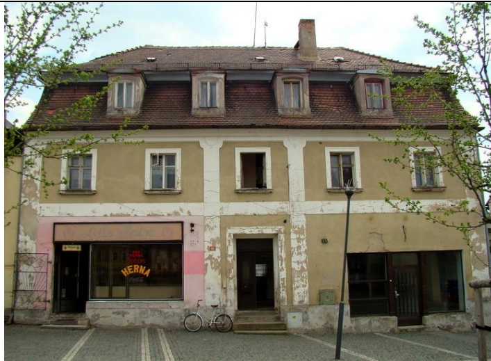
Hlavní severní průčelí, r. 2013
