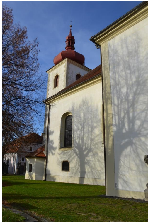
Jižní průčelí, r. 2022
