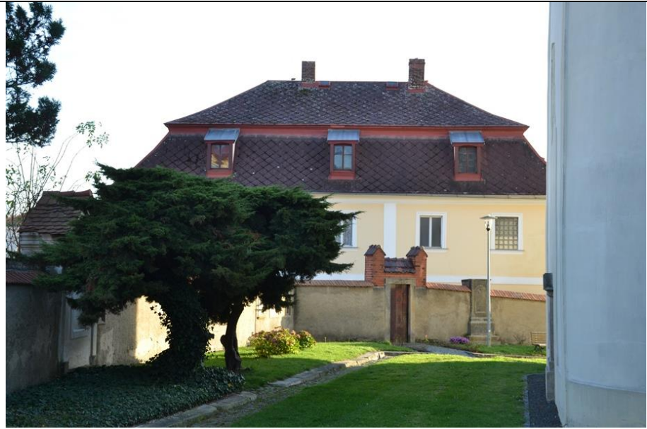
Severní dvorní průčelí, r. 2022
