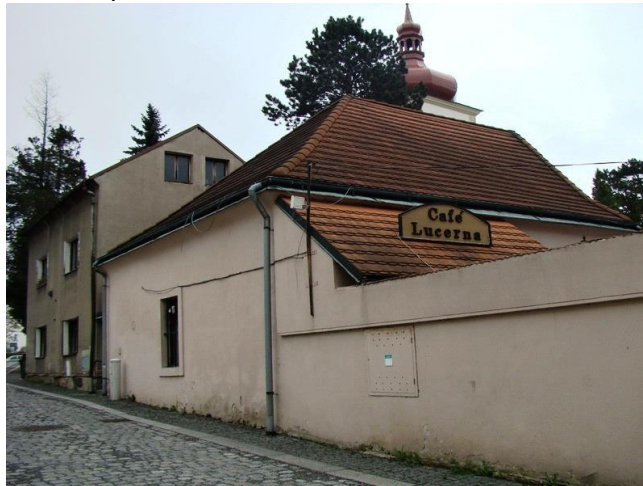
Objekt Městské policie, severní průčelí, r. 2013
