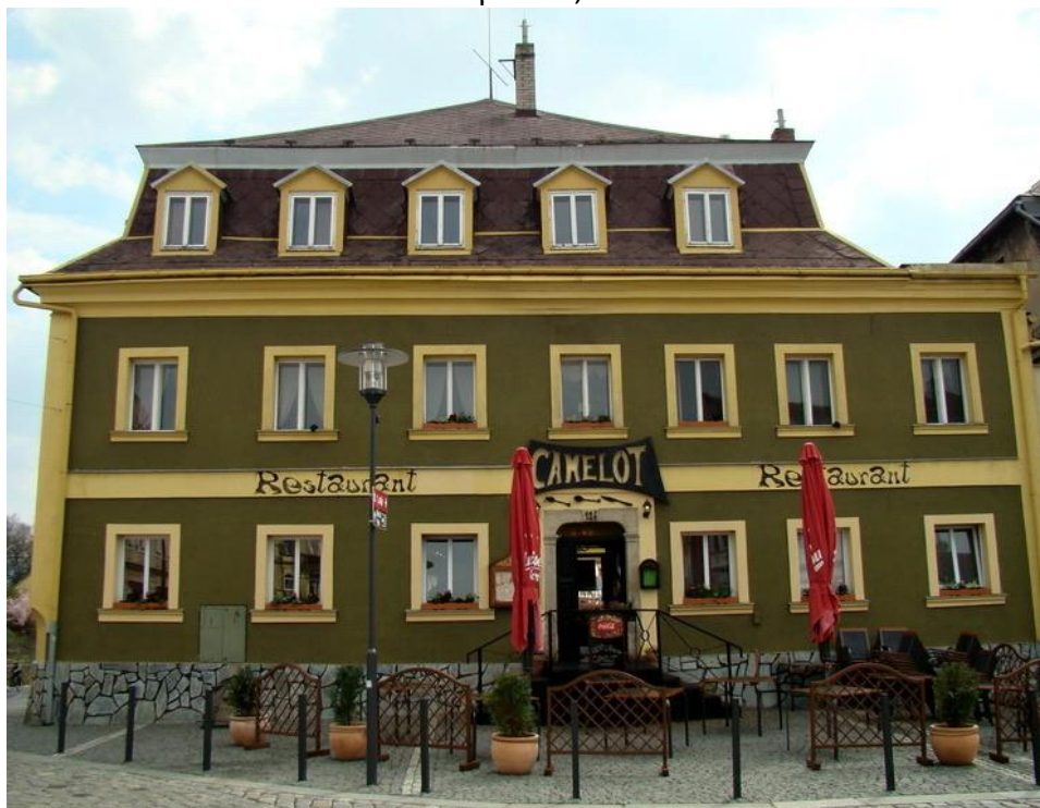
Severní průčelí, r. 2012
