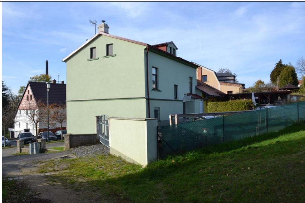
Jižní a východní průčelí, r. 2022
