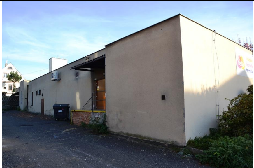
Severní průčelí, r. 2022
