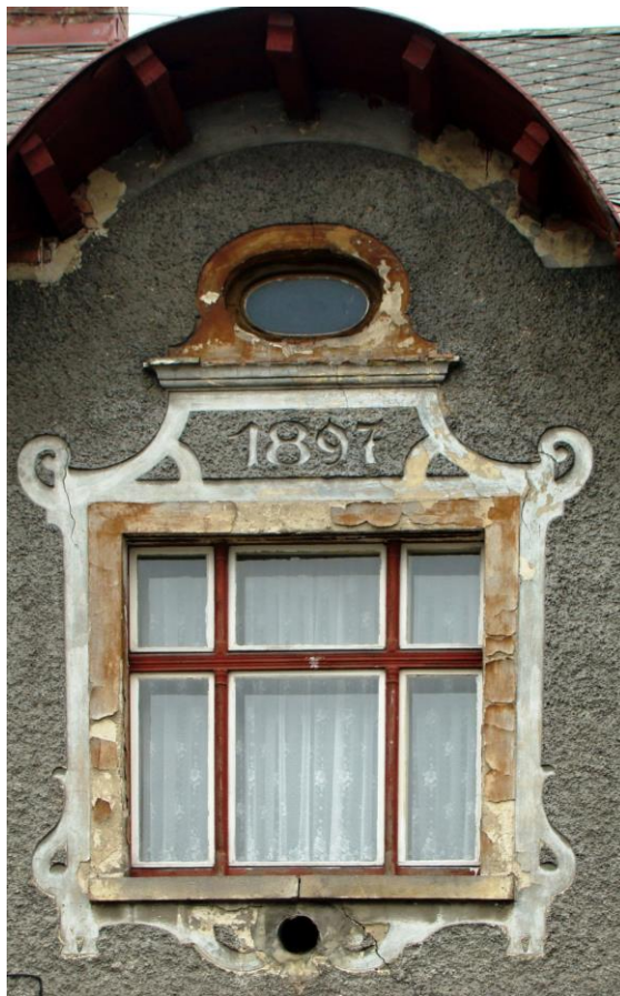
Detail východního průčelí s datací, r. 2013
