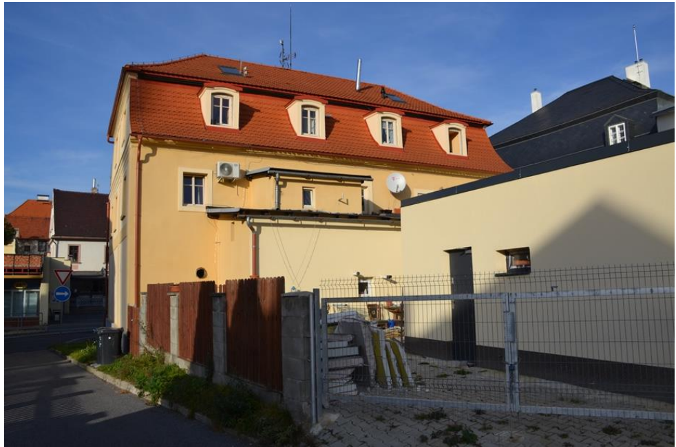
Jižní průčelí, r. 2022
