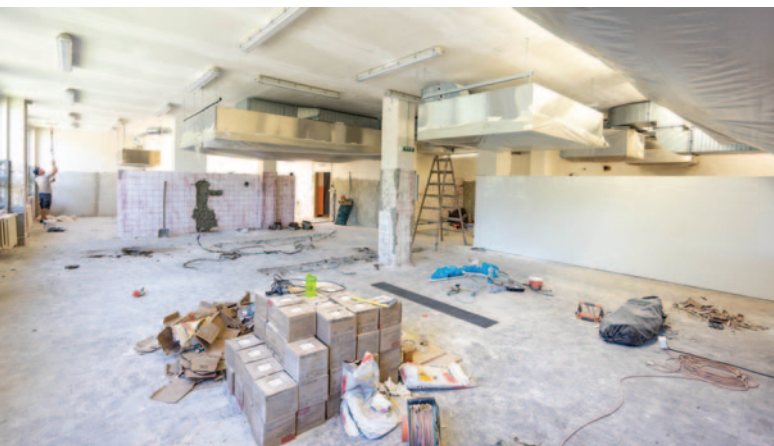
Probíhající opravy kuchyně na ZŠ T. G. M.
