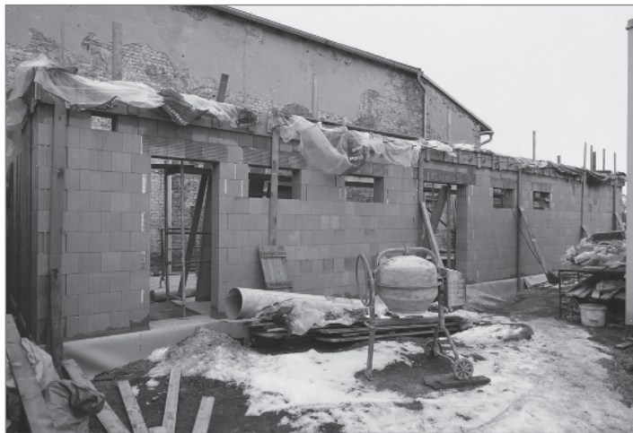
Výstavba sociálních zařízení DK Beseda
