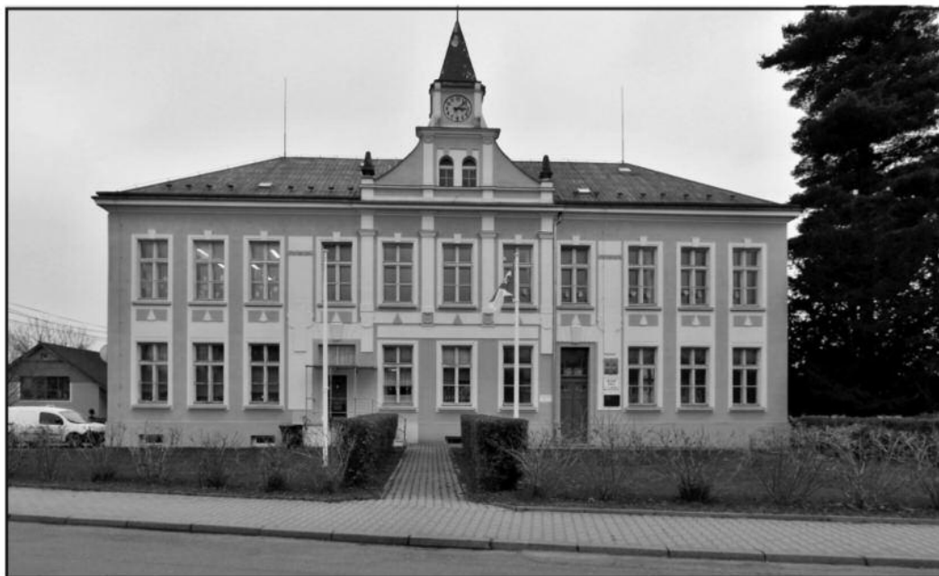
Největší investiční akcí roku bude snížení energetické náročnosti budovy ZŠ Donín.
