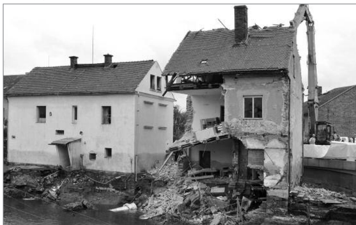
Demolice č. p. 1, Foto: V. Štrupl
