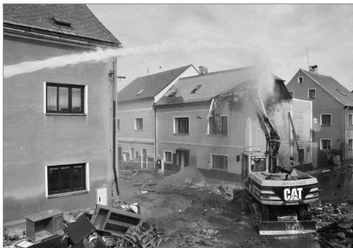
Demolice prvního domu, Foto: V. Štrupl
