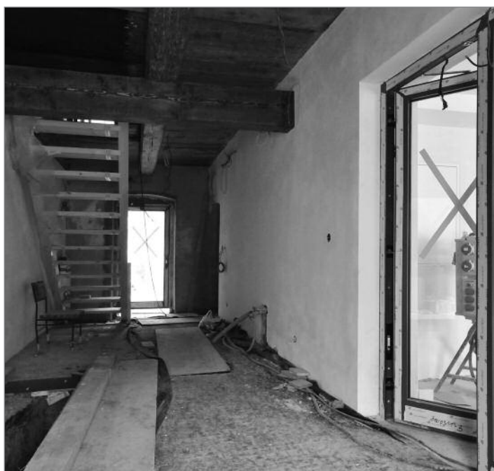
Chodba v přízemí, vpravo informační centrum
