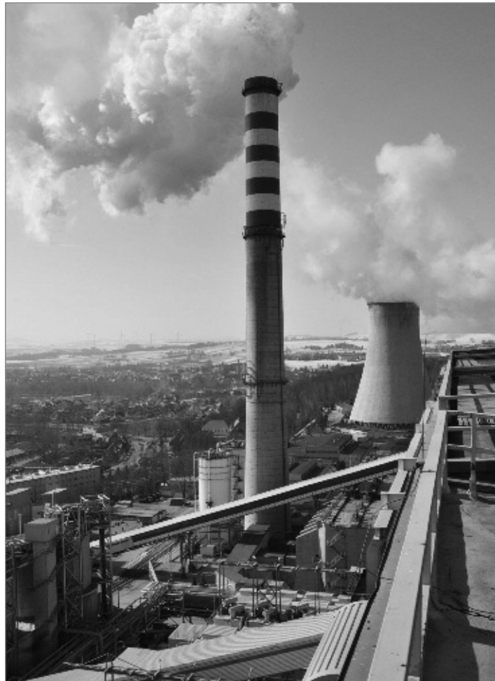
Pohled ze střechy elektrárny
