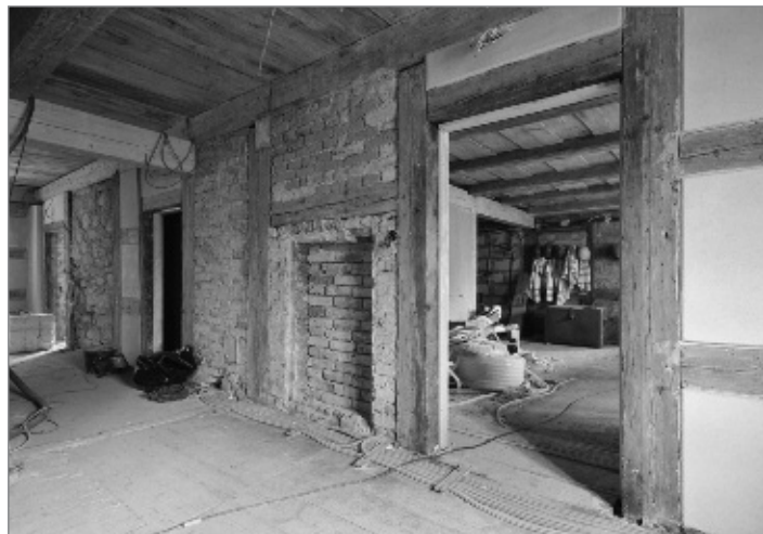
Chodba v prvním patře hrázděného domu
