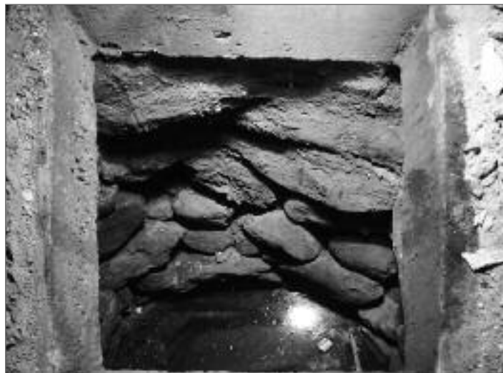
Odkrytá studna ve sklepech domu č. p. 71
