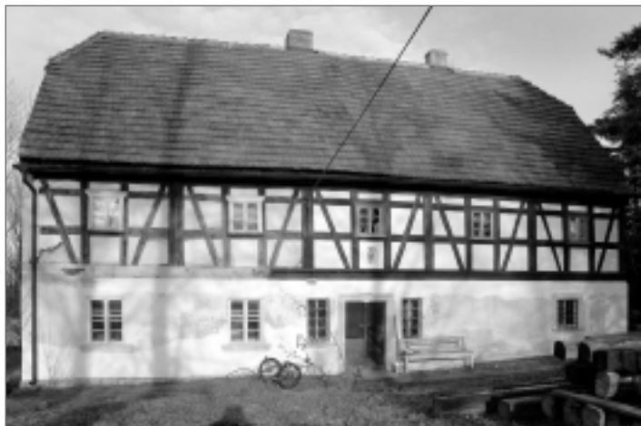
Dům na Uhelné sice nepatří mezi kompletní podstávkové domy, ale měl štěstí na majitele, který jej vysoce fundovaně opravuje. Množstvím dochovaných autentických prvků a kvalitou prvků nových je dům unikátní.
