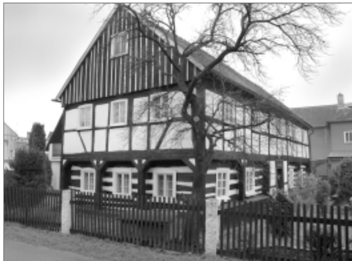
Podstávkový dům, spodní část téměř komplexně roubená, horní hrázděné patro nasazeno na podstavce. Jeden z nejzachovalějších hrádeckých podstávkových domů.
