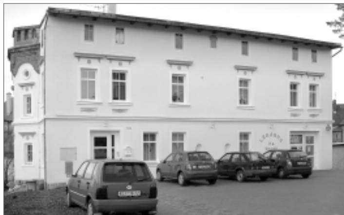
Příklad opraveného domu s dochováním architektonických prvků, pohledové cihelné zdivo arkýře oživuje celek a činí jej krásným.
